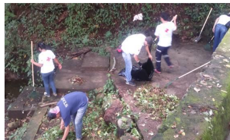
Mejoramiento del sistema de agua de la Comunidad Cebadilla
